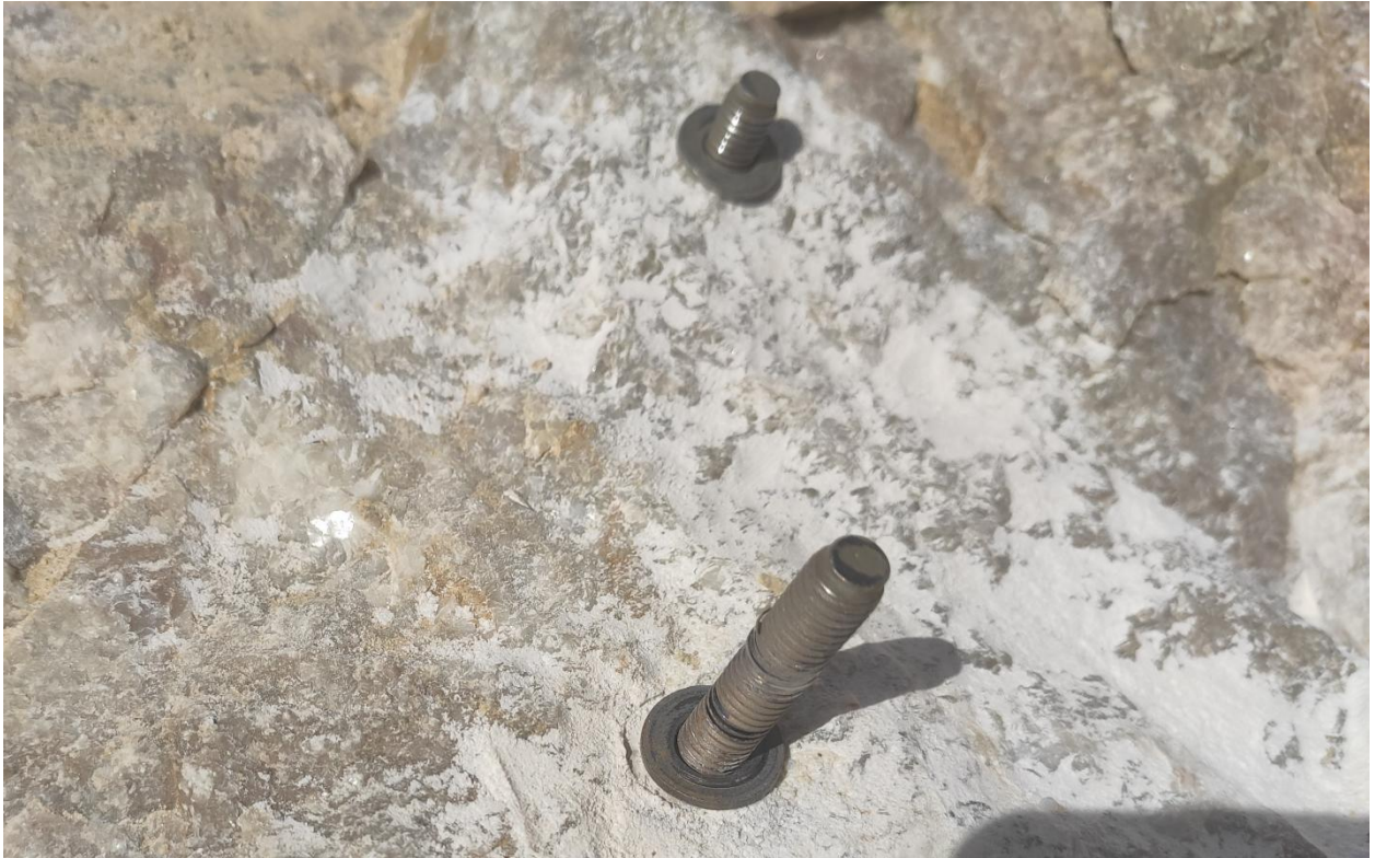
Fotografija 4. Testiranje sidrenog vijka Mungo 15 Nm (Goran Jerković)
